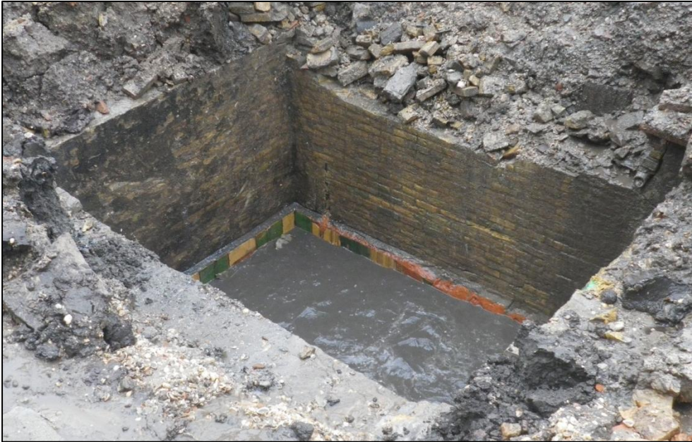
Figuur 7: Waterkelder S20.
